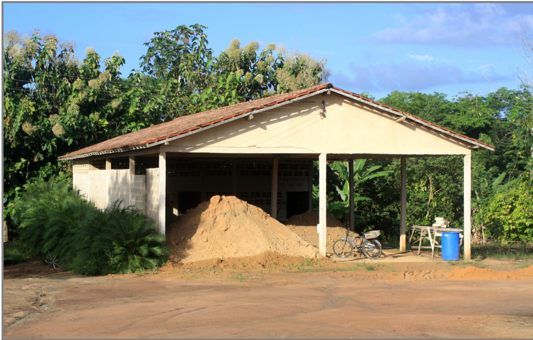
Galpão de 10x20 m 2 e laterais abertas para preparo de substrato para mudas, beneficiamento de sementes etc.
