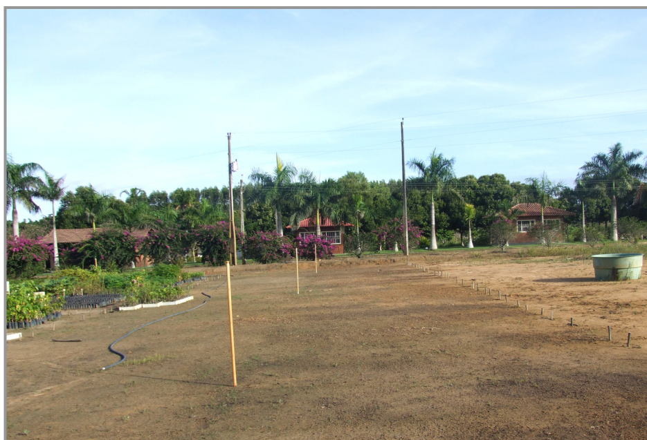
Área de terraplanagem com aspersores para irrigação
